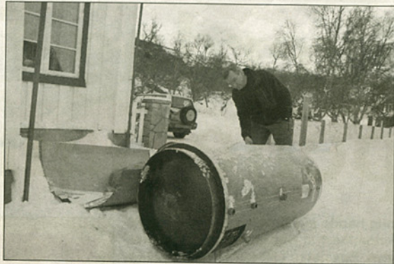
Under årets vedlikeholdsarbeid er fyrkjelene skiftet ut med nye og mer energibesparende løsninger.
