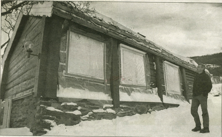
Knut Nyhus inspiserer Karstuggu som skal få «nye» vinduer. Vinduene er tatt ut for å bli reparert og malt.
